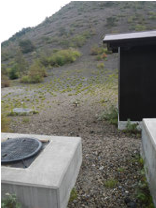
写真 3 C 点予定地. 防災科学技術研究所 AMKV 敷地内. 写真中央の杭が予定地点
