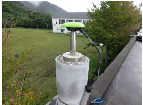
写真 12. ESNZ におけるアンテナ交換後。
