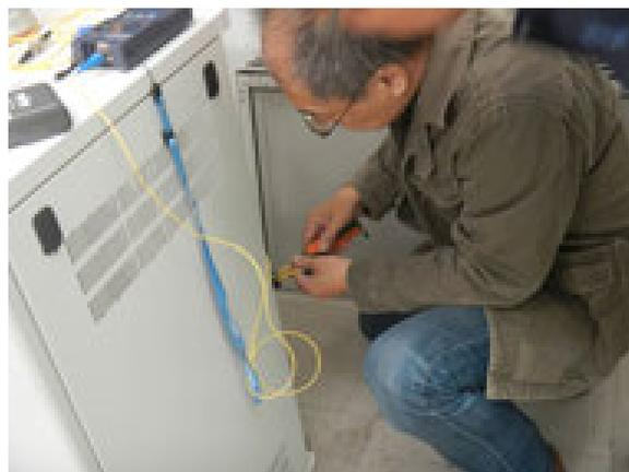
写真 6 光ケーブル空き芯線の通信テスト
