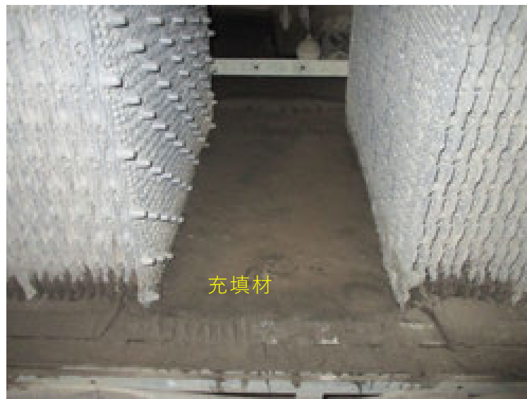
写真14. 冷却塔内部 (終了時)
