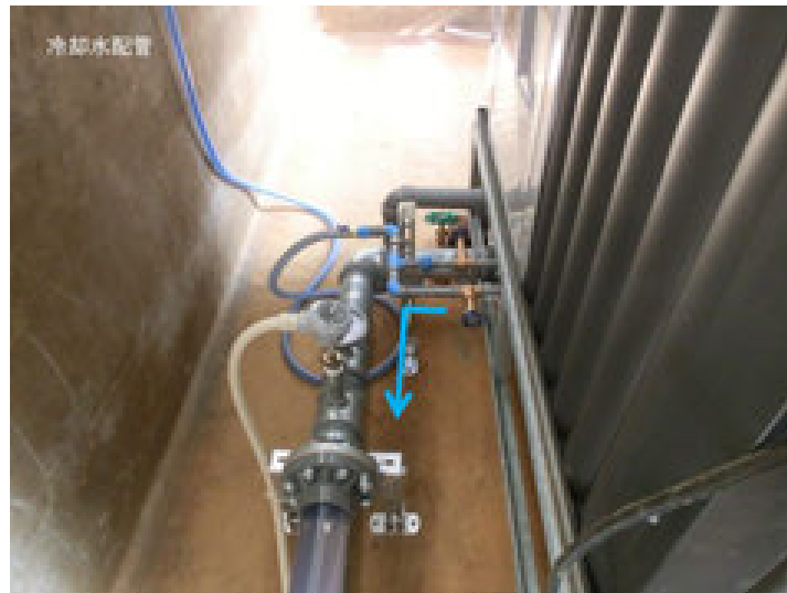
写真7. 冷却水配管
