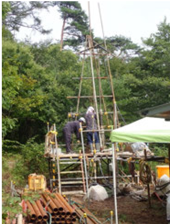
図 5 2 万山望北西ボーリングの掘削風景。
