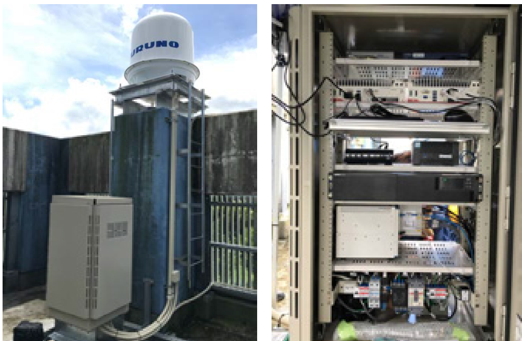
図 3 レーダーの設置状況。霧島市立牧園中学校に設置したもの。
