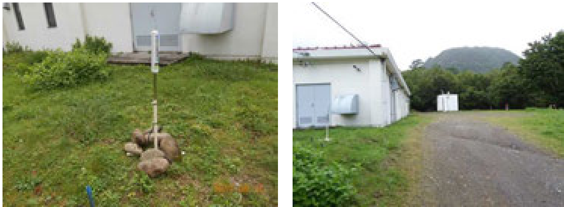
写真 4 GPS アンテナ設置
