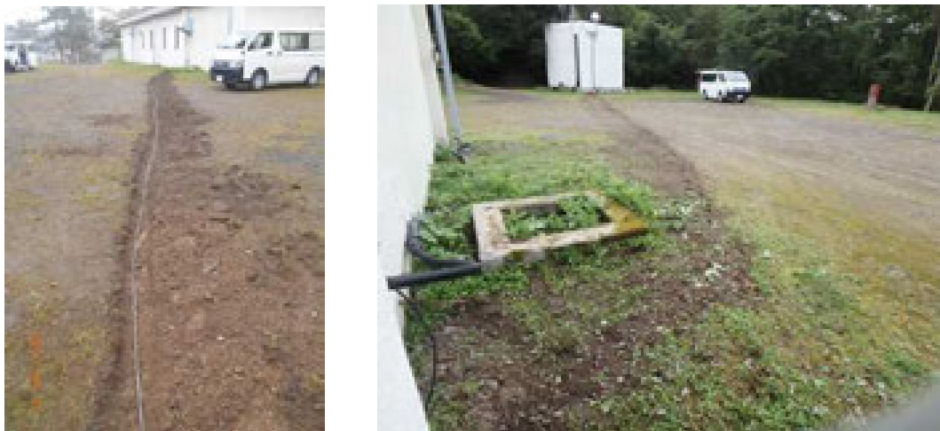
写真2 光ケーブル埋設前（左），および埋設後（右）。
