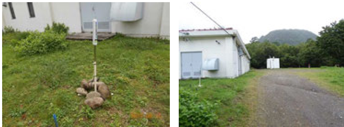
写真4 GPS アンテナ設置
