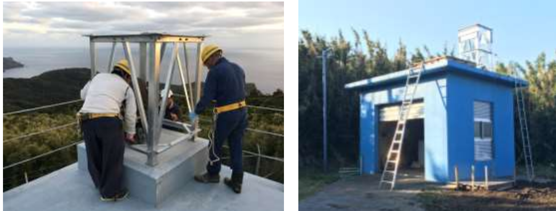
図2 レーダー架台の設置状況。左：口永良部島、右：竹島
