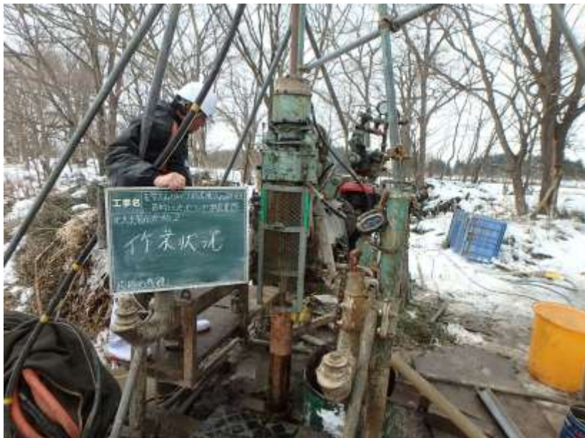
写真2 南西北海道でのボーリング掘削調査の様子（左）とボーリングコア写真（右）。南西北海道は比較的積雪が少なく、ボーリング掘削調査が可能であったため、南西北海道の活火山の噴火履歴を検討するために、これら火山の東方（千歳市）において実施した。
